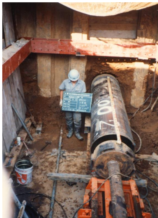
水平ボーリング φ700m/m×20m
