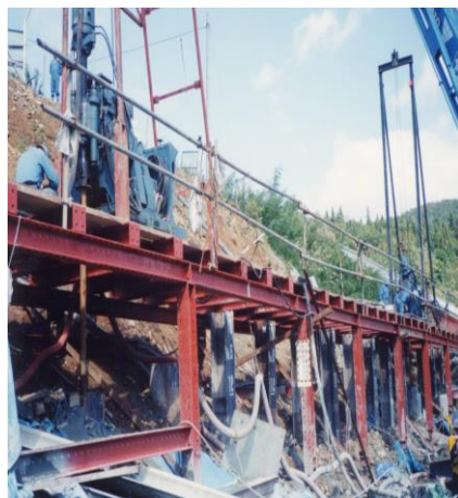
抑止杭削孔状況
