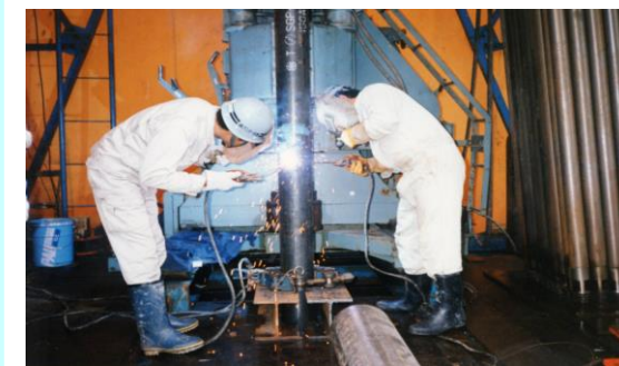
ケーシング挿入状況
