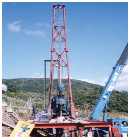
抑止杭削孔状況
