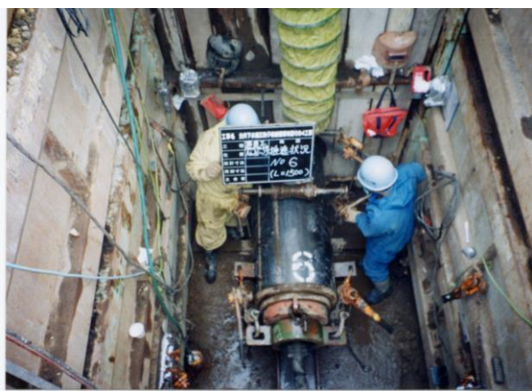
衝撃式推進（鋼管400m/m）
