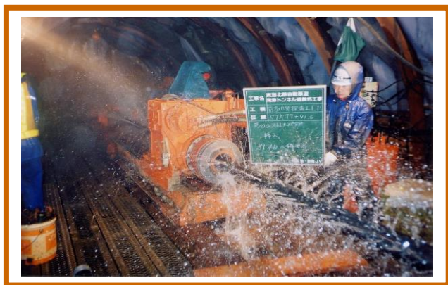
φ100ストレナーパイプ挿入状況
