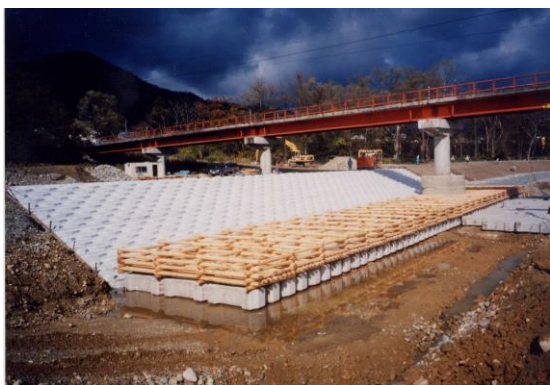
八年橋護岸工（木工沈床工）
