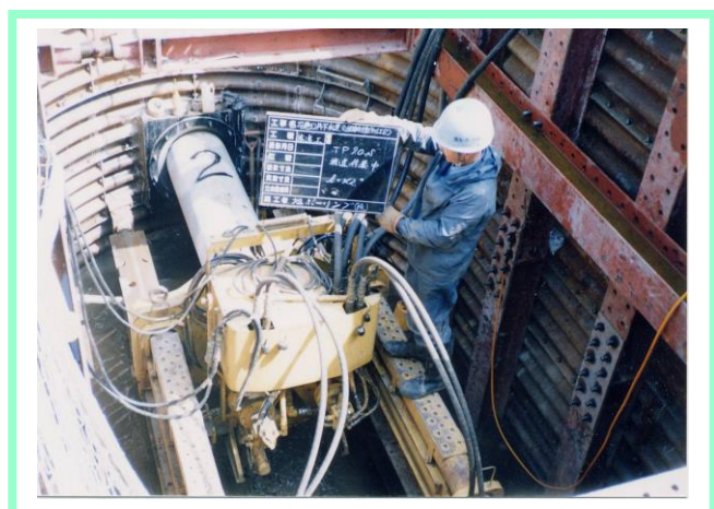
小型立坑対応型推進 (先導管HP250m/m)
