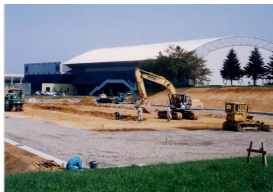
北上総合運動公園駐車場整備工事
