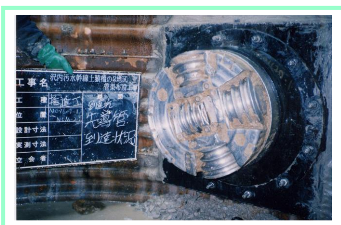
ディスクカッター到達状況 (φ500m/m)
